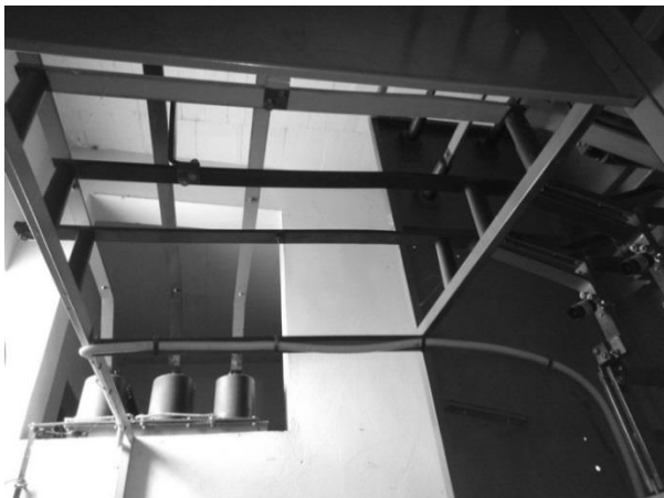
SLIKA 5 – DELOVI 20 KV RAZVODA VAN ZONE ŠTIĆENJA DIFERENCIJALNE ZAŠTITE KOD POSTROJENJA NA SPRATU I U METAL OKLOPLJENIM ĆELIJAMA
