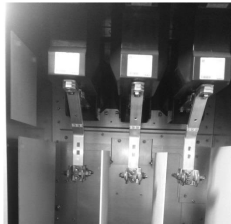
SLIKA 5 – DELOVI 20 KV RAZVODA VAN ZONE ŠTIĆENJA DIFERENCIJALNE ZAŠTITE KOD POSTROJENJA NA SPRATU I U METAL OKLOPLJENIM ĆELIJAMA
